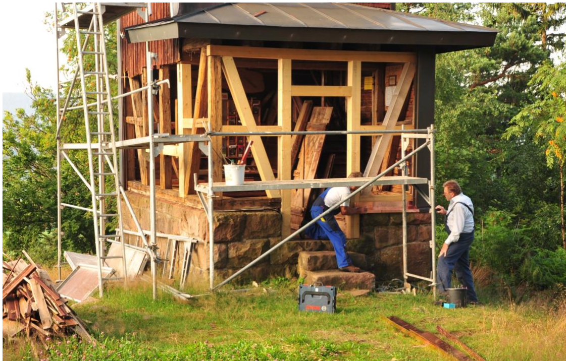
Die tragende Balkenkonstruktion musste weitgehend erneuert werden
