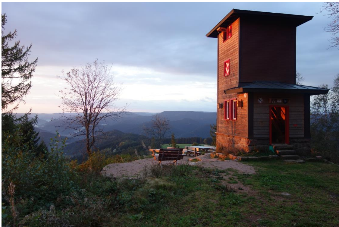
Der sanierte Theisenkopfturm und die neu geschaffene Außenanlage
